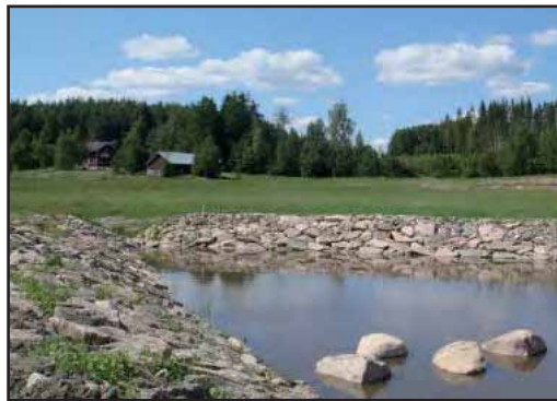
Linnanniitun hulevesien laskeutusallas.
