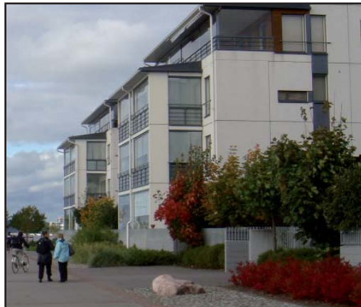
Rakennukset yhdessä muurin, aidan ja istutusten kanssa rajaavat piha-alueen kadun suuntaan.
