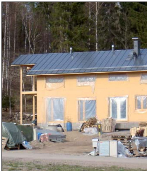
Ekokylään rakenteilla oleva asuinrakennus.
