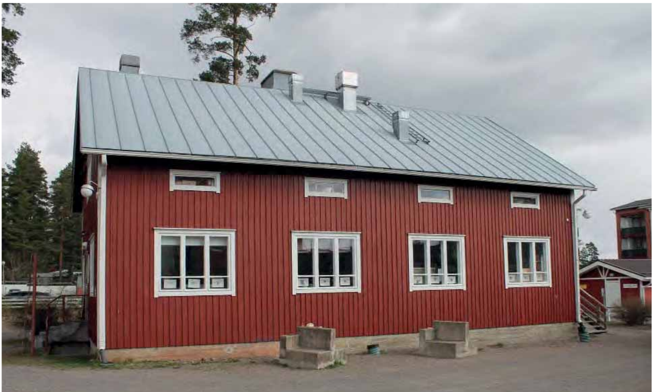
Aatteenpuistossa sijaitseva Vihdin Kuvataidekoulun käytössä tällä hetkellä oleva rakennus.
