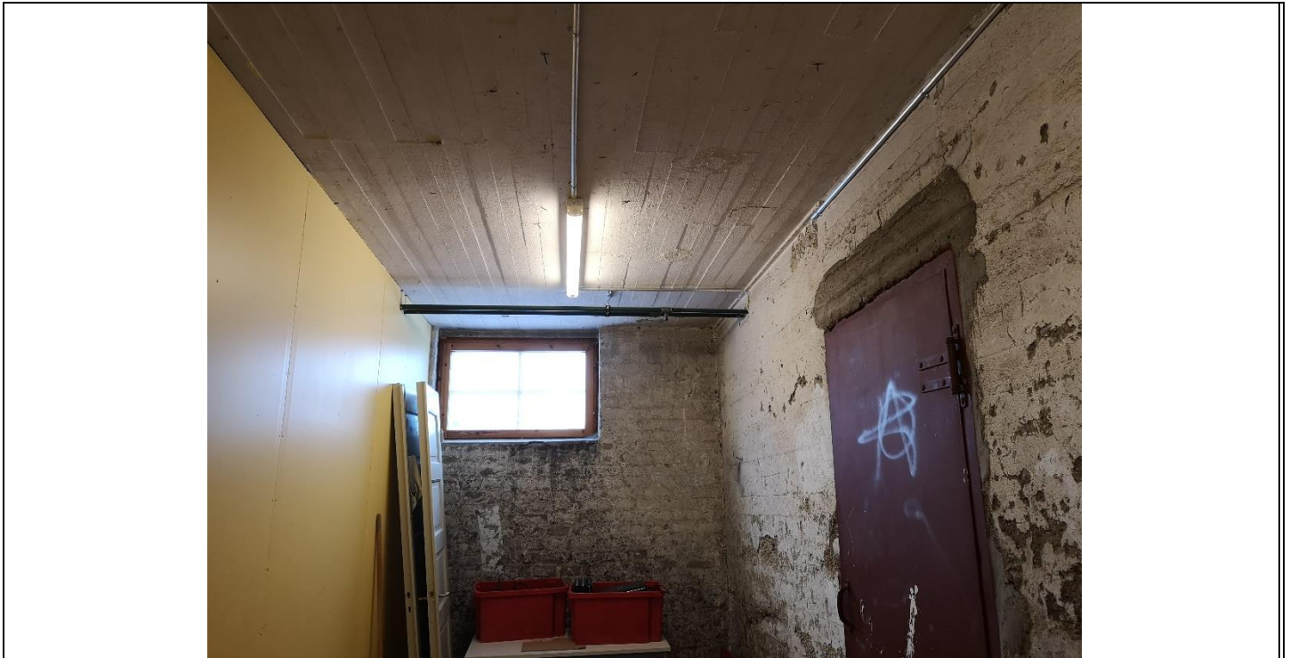
Kuva 8. Rakennuksen eteläisessä päädyssä on kellaritiloja. Kellaritilat on erotettu opetustiloista ovella ja niissä on oma koneellisella poistomurilla toimiva ilmanvaihto/ alipaineistus. Aistinvaraisesti kellaritiloissa ei ollut havaittavissa merkittäviä hajuja ja tilat olivat kohtalaisen siistit.
