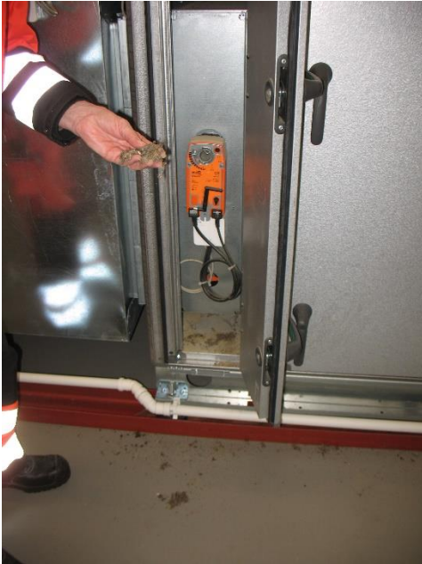
Kuva 2. Ilmanvaihtokoneiden ulkoilma- ja tuloilmaosat tulee puhdistaa sisäpuolelta säännöllisesti.
