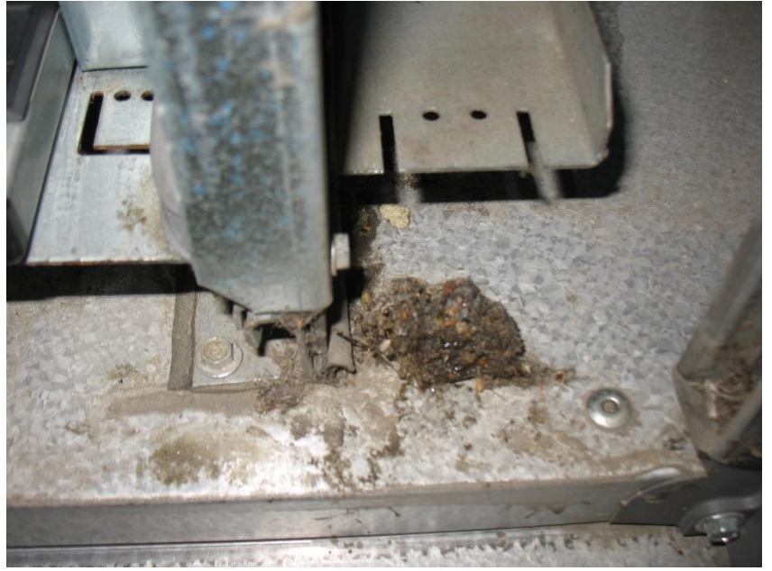
Kuva 2. Ilmanvaihtokoneiden ulkoilma- ja tuloilmaosat tulee puhdistaa sisäpuolelta säännöllisesti.
