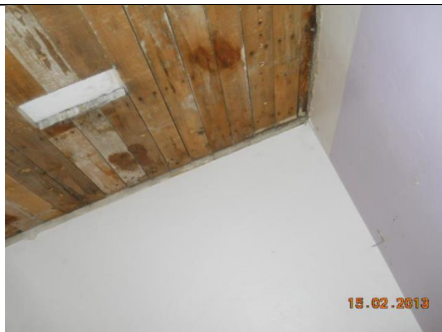
Kuva 7. Lähtötietojen perusteella /2./ yläpohjarakenne on korjattu 2018 poistamalla sisäkaton rakenteet yläpohjan kantavien rakenteiden alapinnassa olevaan laudoitukseen asti ja korjaamalla yläpohjan ilmanpitävyyden puutteita. Kuva /12./.
