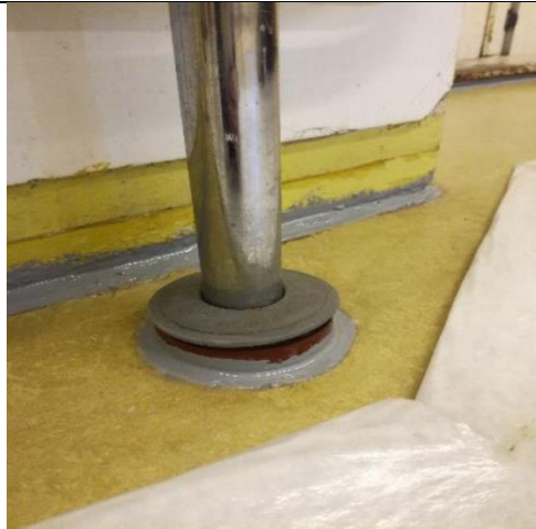
Kuva 3. Korjattu läpivienti ja liitos /18./.
