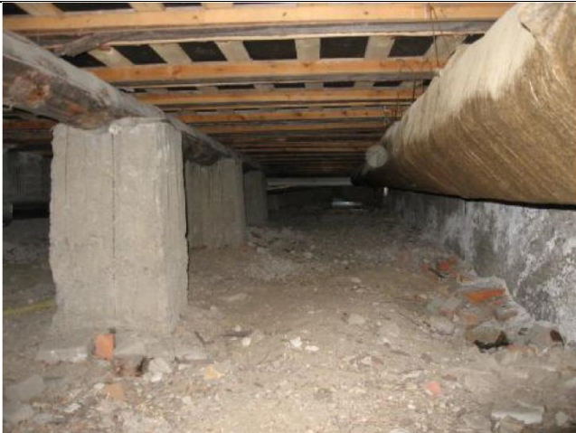
Kuva 2. Puurakenteinen alapohjarakenne /8./.
