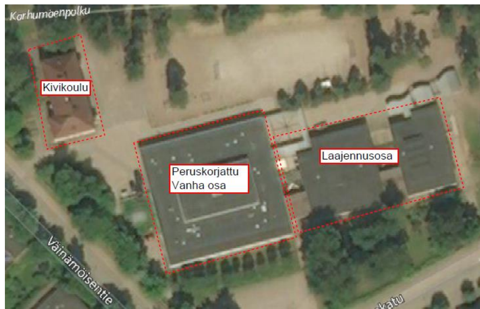
Kuva 1. Koulun rakennukset nimettynä ilmakuvassa.
