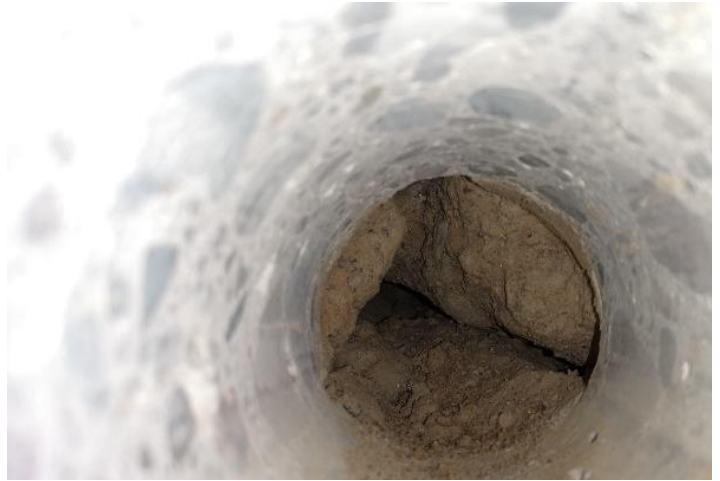
Kuva 18. Rakenneavaus tehtiin putkikanaalin seinän läpi alapohjalaatan alapuolelle. Pohjalaatan alapuolella on hiekkaa. Muottilautoja tai vettä ei tilojen alta rakenneavauksessa havaittu.
