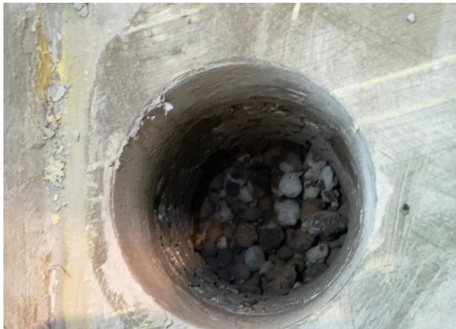
Kuva 15. Rakenneavaus 161. Kevytsoakerroksessa ei ollut poikkeavia merkittäviä hajuja. Rakenteessa ei ollut kosteudelle herkkiä materiaaleja, kuten valupaperia tms.
