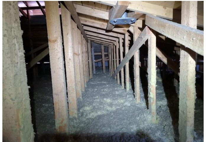
Kuva 6. Yläpohjan tuuletustila luokan 231 yläpuolella. Tuuletustila tuulettuu aistinvaraisesti arvioituna hyvin.
