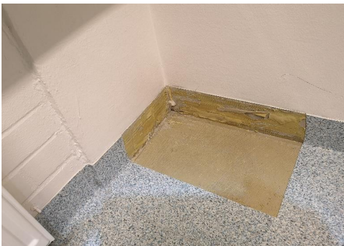
Kuva 14. Ensin avauskohdasta poistettiin muovimatto. Alapohjarakenteen pintalaatan ja seinärakenteiden liitos on tiivis myös muovimaton alla. Rakenneavaus 184b.
