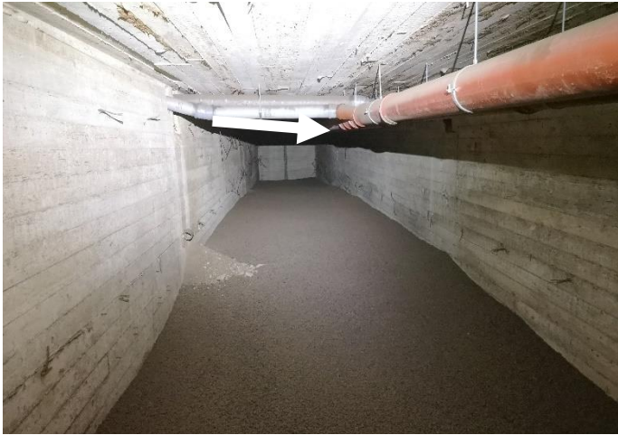
Kuva 17. Putkikanaali tilojen 161-163 käytävän alapuolella. Rakenneavaus (nuoli) tehtiin putkikanaalin seinän läpi alapohjalaatan alapuolelle.
