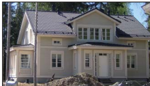
Rakenteilla oleva vaalea puutalo.
