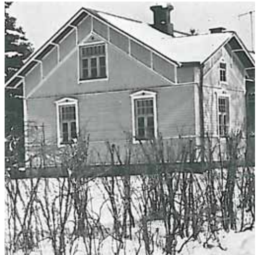
Räyhän päärakennus vuodelta 1905. Ikkunatyypit edustavat hyvin aikakautensa arkkitehtuuria. (Vihdin kulttuurihistorialliset rakennukset ja alueet. Vihdin kunta 1982)
