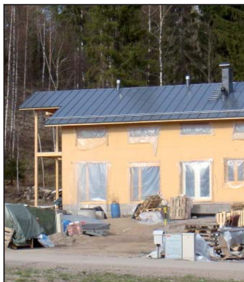
Ekokylään rakenteilla oleva asuinrakennus.
