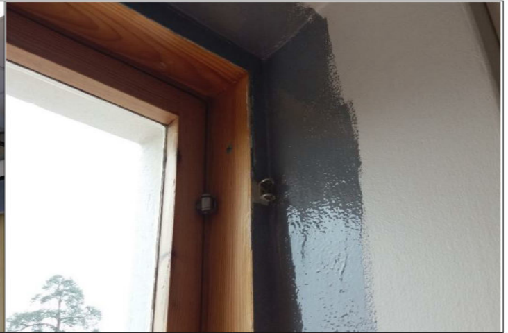
Kuva 21. Ikkunoiden liitos ulkoseinärakenteeseen on tiivistetty vuonna 2018 tehdyssä korjauksessa. (kuva KMAC)
