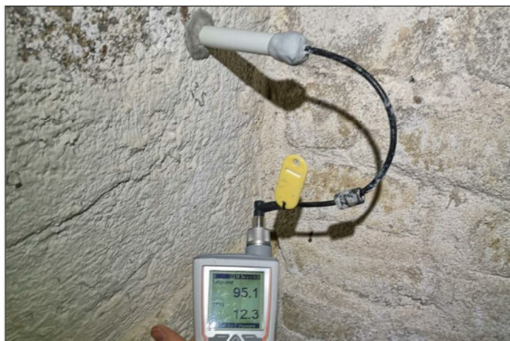
Kuva 6. Porareikäkosteusmittaus väliseinästä (K2).
