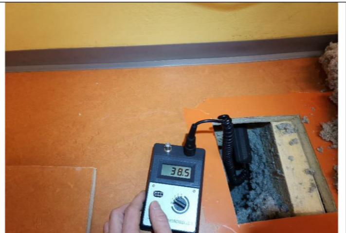
Kuva 11. Rakenneavauksen kohdalla ei ollut kosteutta puurakenteissa tai viereisessä ulkoseinässä sisäpuolella.
