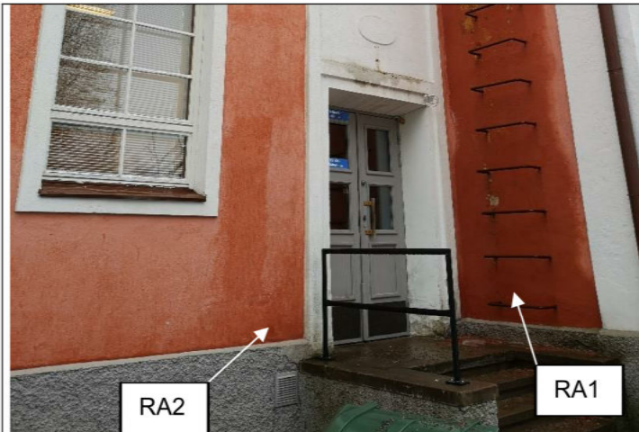
Kuva 10. Rakenneavausten RA1 ja RA2 kohta ulkopuolella. Ulkoseinän ulkopuolella on sisäänkäyntitaso.
