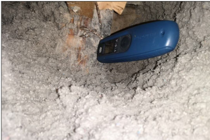
Kuva 14. Puurakenteet olivat kovia ja kuivia (puurakenteiden kosteus oli alle 10 p-%).
