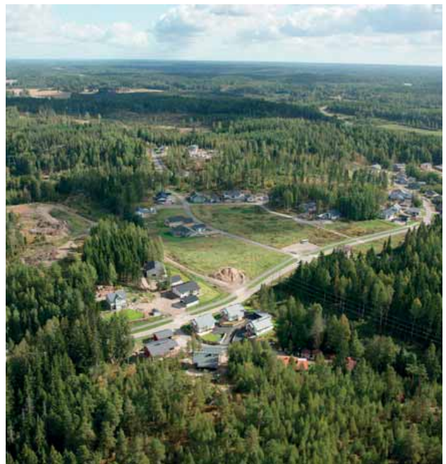
Ilmakuva rakentumassa olevasta Linnanniitusta.
