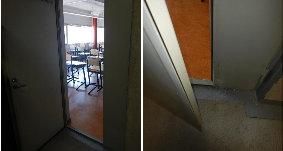
Kuva 4. Portaikon 208 oviaukko. Oven ja karmin liittymiin on asennettu tilkenauhaa, joka estää ilmavirtauksia oven rakojen kautta. Lisäksi karmin ja lattian liitos on tiivistetty.
