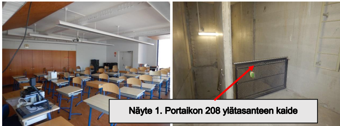
Kuva 1. Ensimmäinen näyte otettiin portaikon 208 ylätasanteen kaiteen päältä.
