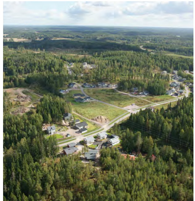
Ilmakuva rakentumassa olevasta Linnanniitusta.
