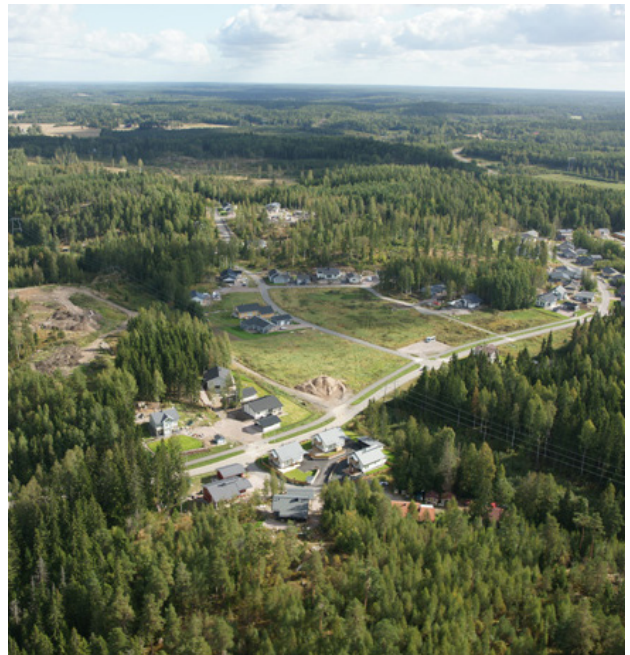
Ilmakuva rakentumassa olevasta Linnanniitusta.
