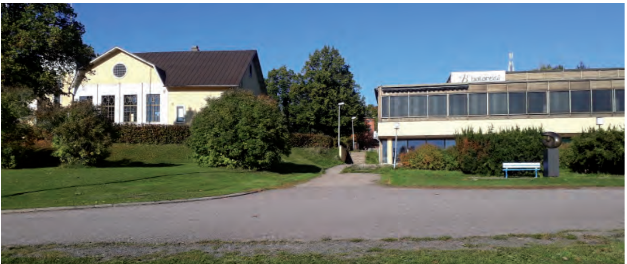
Vihdin kunnan 1910- ja 1970 -luvuilla valmistuneet kunnantalot.
