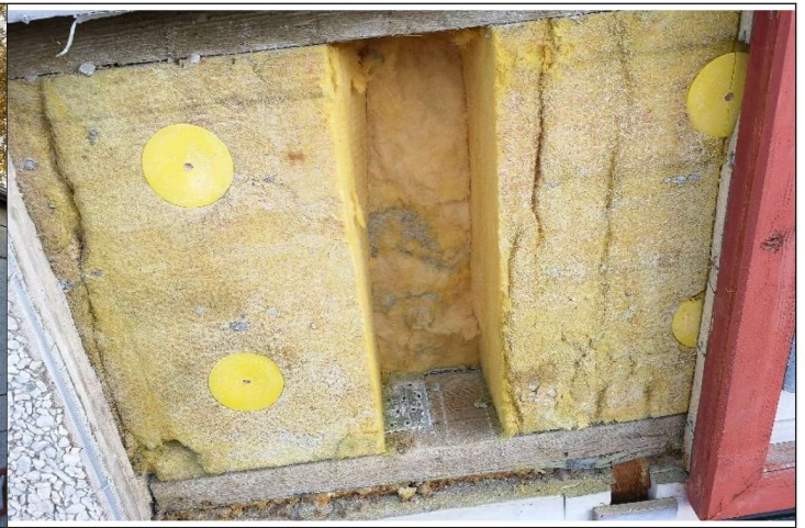
Kuva 4. RA1. Rakenneavausten perusteella betonisen sisäkuoren ja pesubetonisen ulkokuoren välissä oleva lämmöneriste on lasivillaa. Puujulkisivun yläpuolella betonielementin vaihtuessa lämmöneristeenä on yläpohjan osalla EPS:ä. Ikkunoiden apukarmit ovat puuta.
