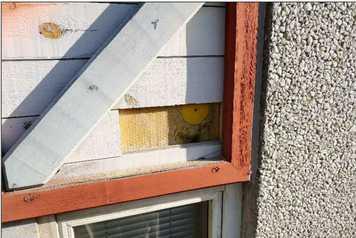
Kuva 7. Rakenneavaus R2 tehtiin lähelle syöksytorvea.
