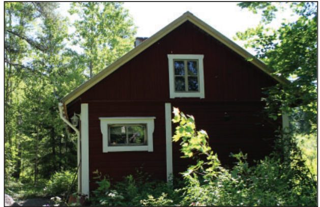
Honkalan (ent. Riikola) saunarakennus, jota on myös korjattu viime vuosien aikana.
