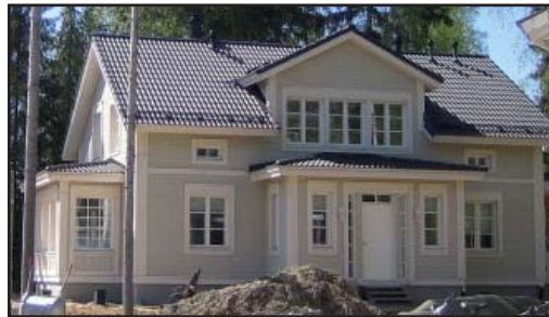
Rakenteilla oleva vaalea puutalo.
