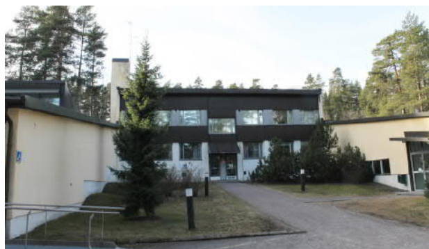
Yllä olevat valokuvat Palman rakennuksesta.
