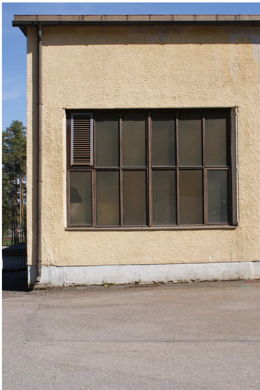
Julkisivuote pihan puolelta
