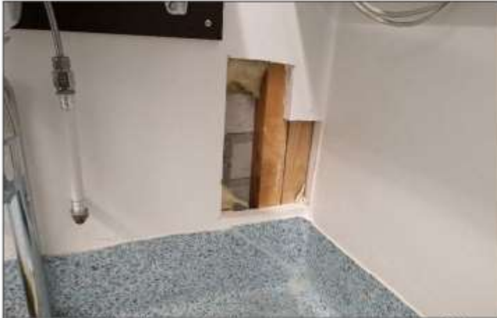
Kuva 14. Väliseinään tehtiin rakenneavaus luokan 233 puolelta. Luokan 233 puolelta on väliseinään puukoolattu kipsilevyrakenne ja lämmöneristeenä on lasivillaa.
