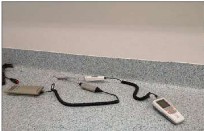
Kuva 10. Luokka 233. Luokan 233 ulkoseinän lähellä pintakosteusilmaisimen lukemat lattiassa vaihtelivat välillä GANN 60-70 (normaali kosteus).
