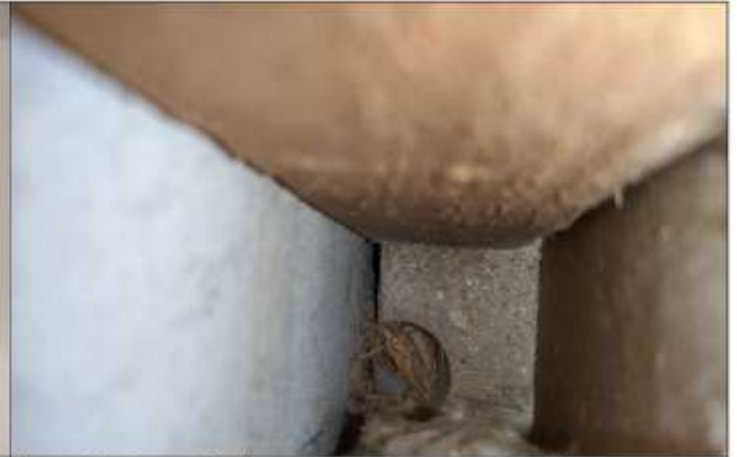
Kuva 15. Betonilattiaa vasten olevasta alaohjauspuusta porattiin palanen ja puurakenteiden kosteus mitattiin piikkikosteusmittarilla.
