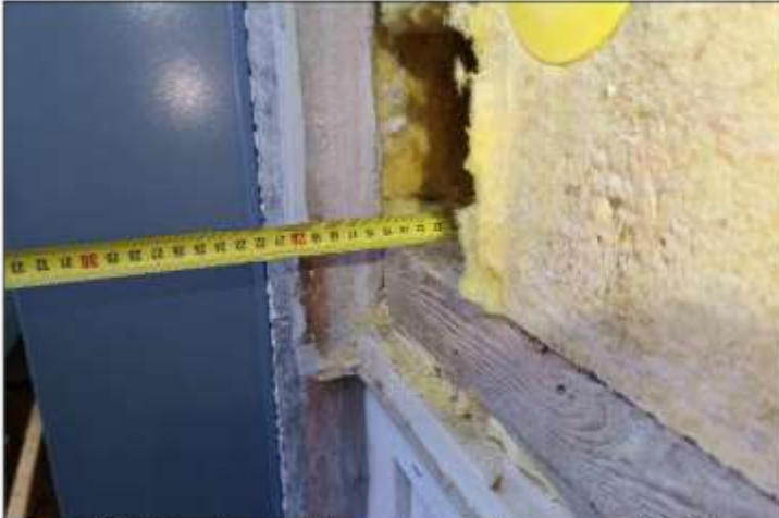
Kuva 18. Lämmöneristekerroksen paksuus on 12-13 cm ja pesubetonisen ulkokuoren on 6-7 cm.
