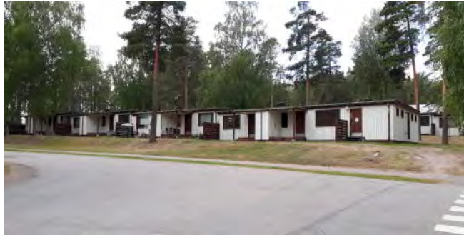
Yksikerroksiset rakennukset Nummenselkä -kadun suunnalta.
