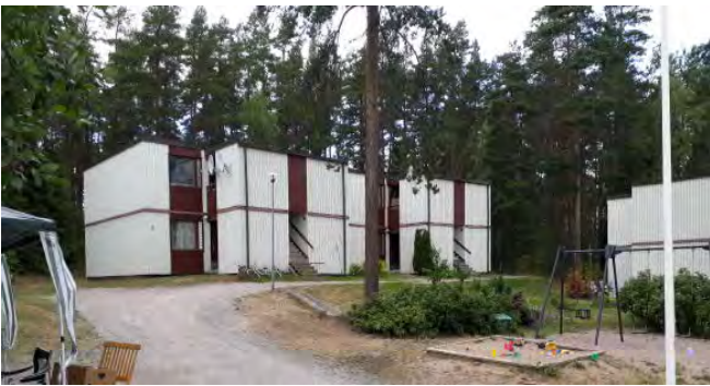
Kaksikerroksisia rakennuksia pysäköintialueelta katsoen
