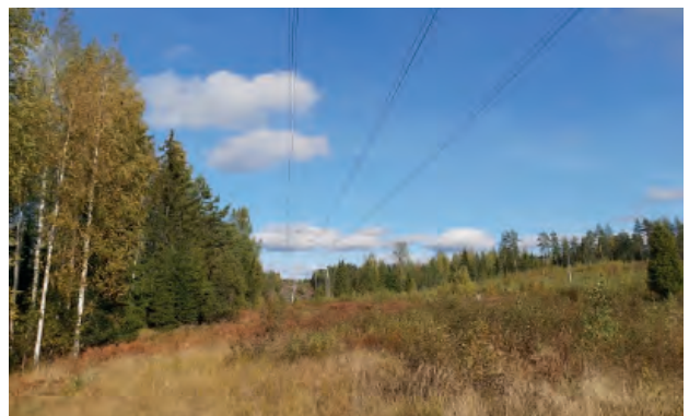
Suunnittelualueetta halkovat sekä 110 kV että 400 kV voimalinjat.
