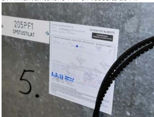
99. Ilmanvaihtokoneet 204 ja 205 suodattimien vaihtomerkinnät ovat alkaen vuodelta 2003.
