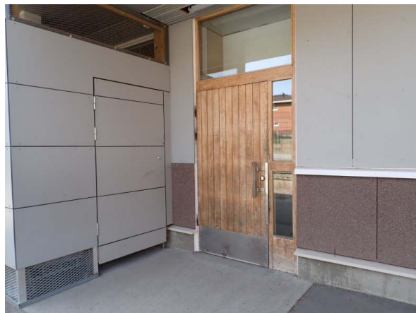
58. Ulko-ovien puupinnoilla on kulumaa ja käsittelytarvetta
