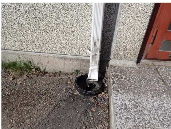
10. Sadevesien poistoa sadevesisuppiloon.
