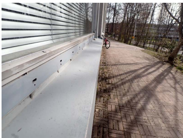
49. Vesipelttien kallistukset ovat riittävät
