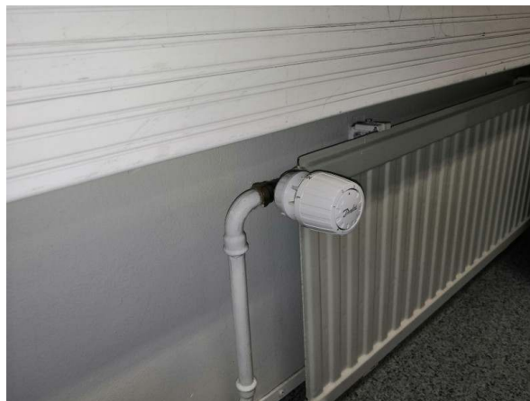
89. Termostaattinen patteriventtiili (laajennus).
