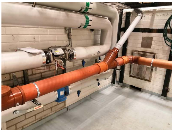
93. Muoviviemäriä lämmönjakokeskuksessa.
