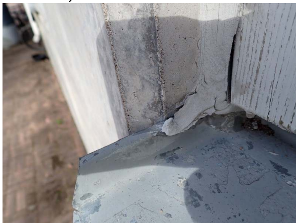
45. Vesipeltien reunoissa on tiivistystarvetta
