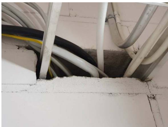
122. Avonainen läpivienti keskiosassa.
