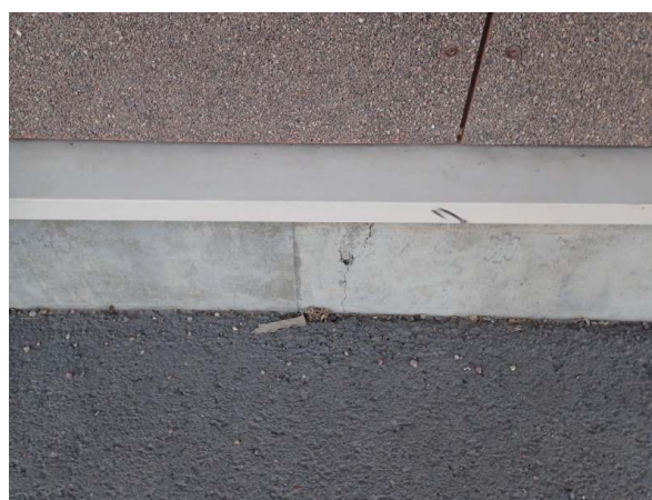
28. Uusittua sokkeliä vanhalla osalla
