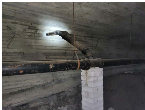
94. Valurautaviemäriä vanhan osan alapohjassa (ilmeisesti sadevesiviemäreitä).
