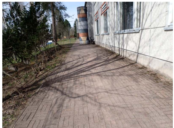
3. Rakennuksen vierustalla on myös betonikivetystä
