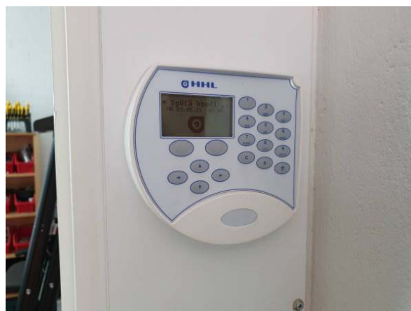
150. Rikosilmoitusjärjestelmän käyttölaite.
