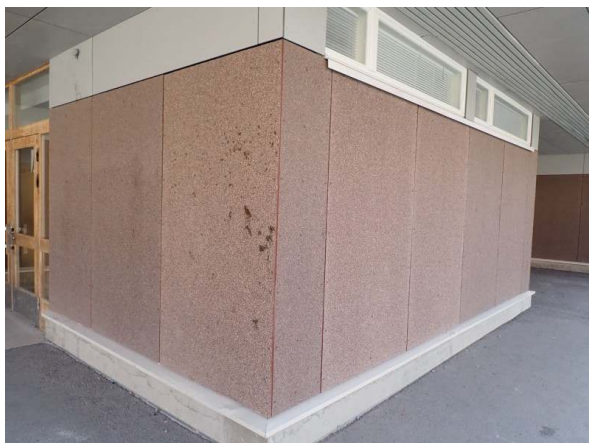
35. Ulkoseinissä olevia verhouslevyjä
