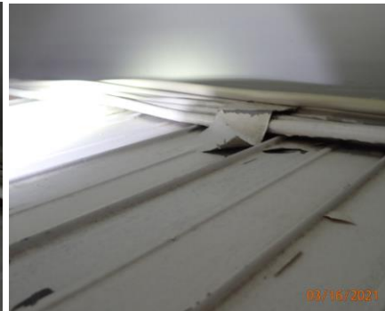
Kuvat 7 ja 8. Ruokalan katonrajan iv-kanavien (kuva 3) yläpinnoilla on vähäisessä määrin pölyä.
