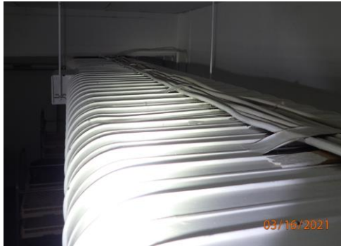
Kuvat 7 ja 8. Ruokalan katonrajan iv-kanavien (kuva 3) yläpinnoilla on vähäisessä määrin pölyä.
