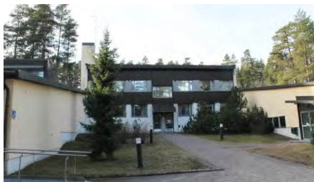
Yllä olevat valokuvat Palman rakennuksesta.
