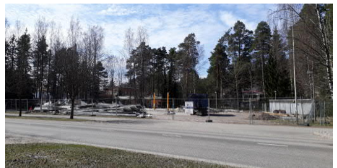
Huoltoaseman purkutöitä. © Vihdin kunta
