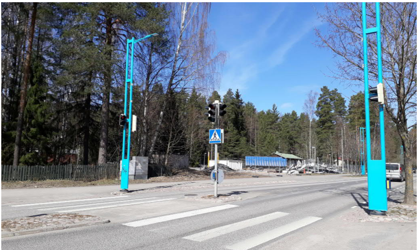
Kuva kaavamutosalueesta Vihdintien ja Lohjantien risteyksestä otettuna. Kuva on otettu huhtikuussa 2021. Nesteen huoltoaseman purkutyöt ovat käynnissä. © Vihdin kunta.
