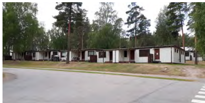
Yksikerroksiset rakennukset Nummenselkä -kadun suunnalta.
