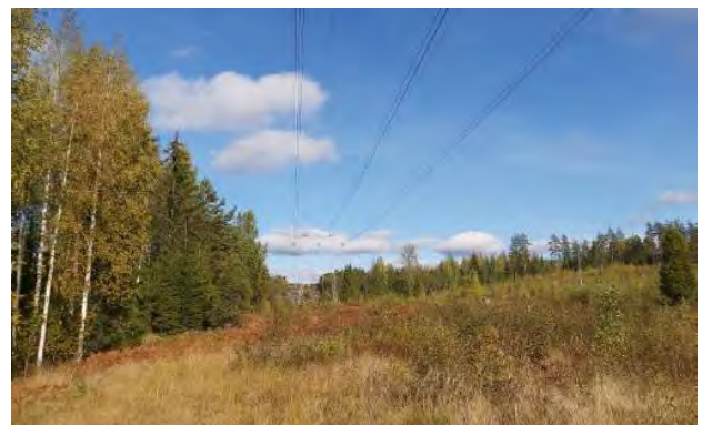
Suunnittelualuetta halkovat sekä 110 kV että 400 kV voimalinjat.
