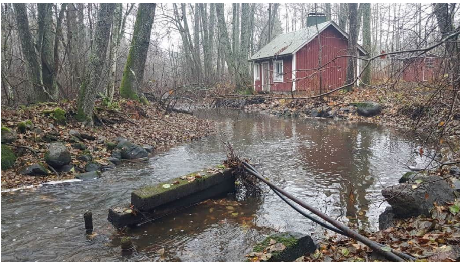
Kuva 26. Myllynpaikalla joenuomassa oli modernihkoja betonisia rakenteita ja käytössä oleva sauna(?)rakennus. Lounaaseen. SK.
