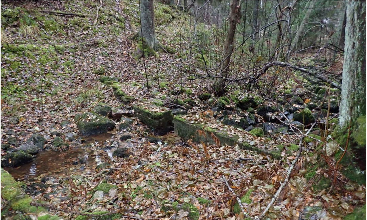
Kuva 23. Jokuoman betoninen rakenne. TT.
