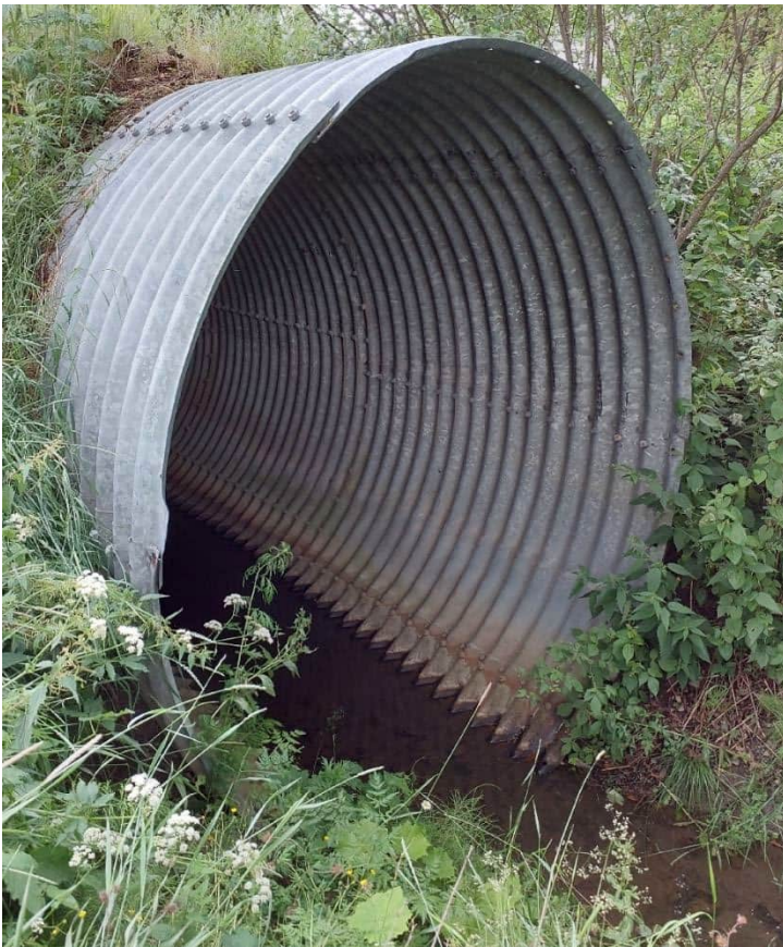
Kuva 43. Suuri metallirumpu, jossa puro alittaa Haimoon Myllytien. Kuva: Riku Kangasniemi.
