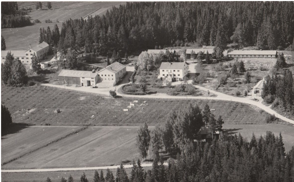
Kuva 30 Karlsbergin (Kallelan) rakennuksia vuonna 1958. Kallelan entinen kattotiilitehdas kuvan vasemmassa reunassa.
