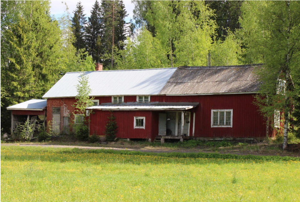
Kuva 28 Väinölän puusepänerstaan rakennus.
