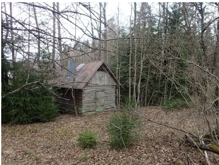
Kuva 12 Syrjämäessä on vielä jäljellä vanhaa rakennuskantaa kohteella 9.
