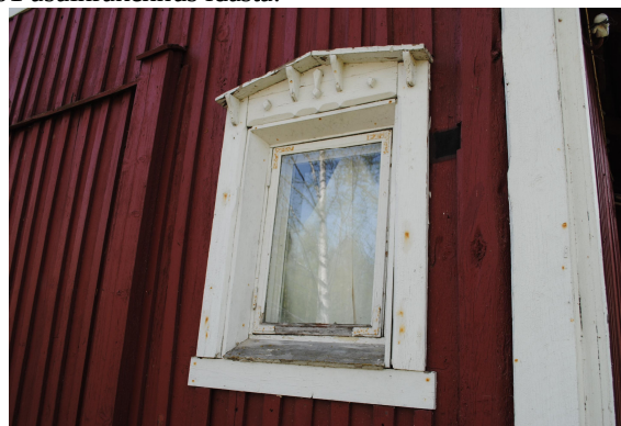
Asuinrakennuksen eteisen ikkunapuitteet.
