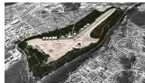
Alueen uudisrakentaminen sijoittuu lentokenttäalueen reunaan.
