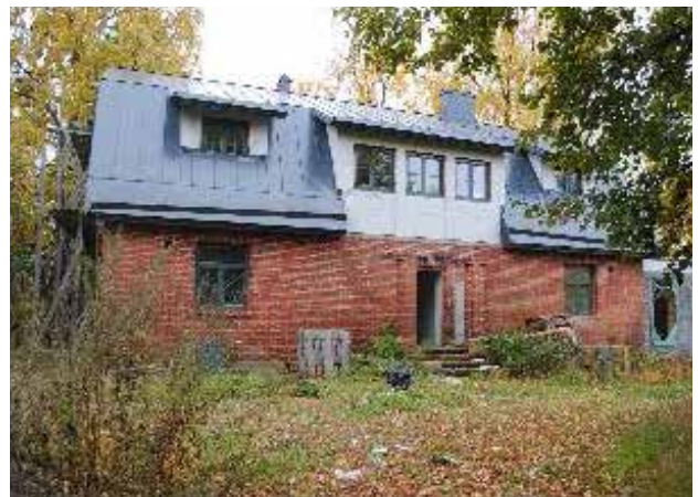
Janttulan tilan päärakennus vuonna 2011 (Kuva: Ojakkalan taajaman inventointi 2013, Vihdin museo).
