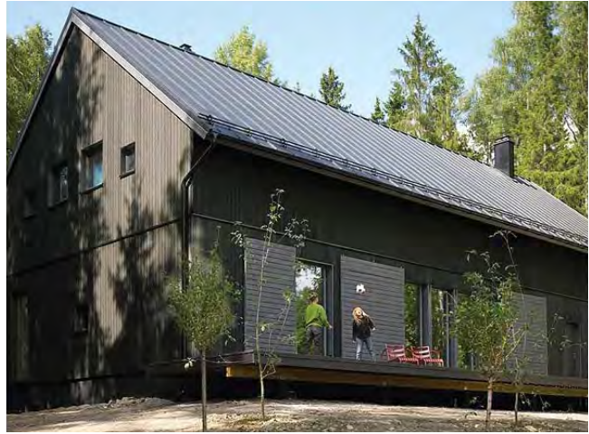
AO-6 -korttelialueilla rakennusten mittasuhteiden tulee olla perinteiset, vaikka arkkitehtuuri muutoin voikin olla modernia.
