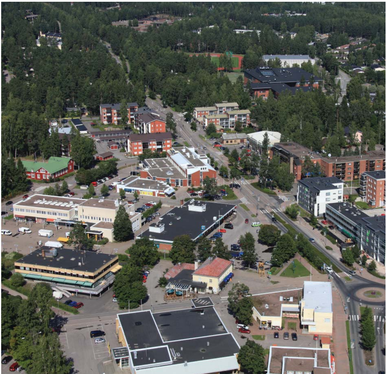
Kuva työväentalosta (kuvan vasemmassa laidassa) ja sen ympäristössä olevista liike- ja asuinrakennuksista Nummelan ydinkeskustassa.
