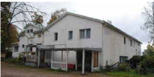
Ylhäällä: Sepän asuinrakennus, taustalla autotalli vuodelta 2014. Alhaalla: Terhelä II. (Kuva: Rakennusinventointi, 2013.)
