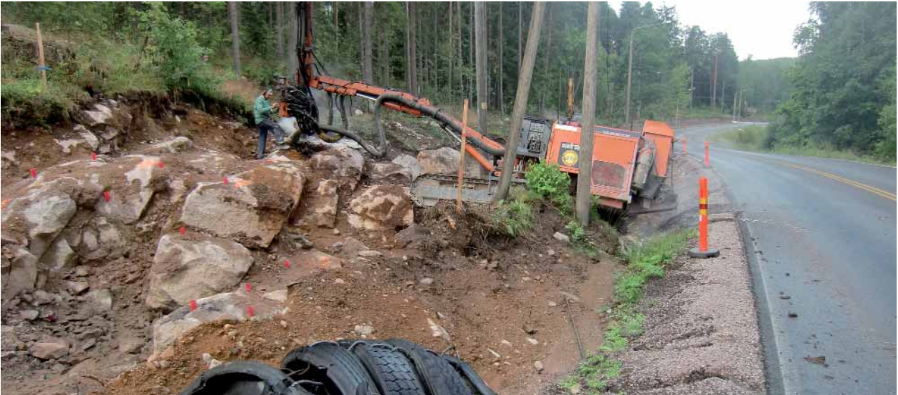
Työmaa kevytliikenteen tien rakentamiseksi Tervalammentielle
