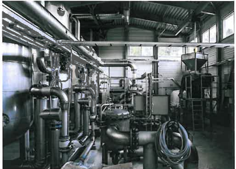
Vihdin Veden päävedenottamon, Luontolan, prosessitilaa
