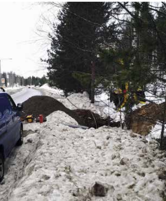
Asemantien vuoto, jonka aiheutti rikkoutunut muoviputki.
