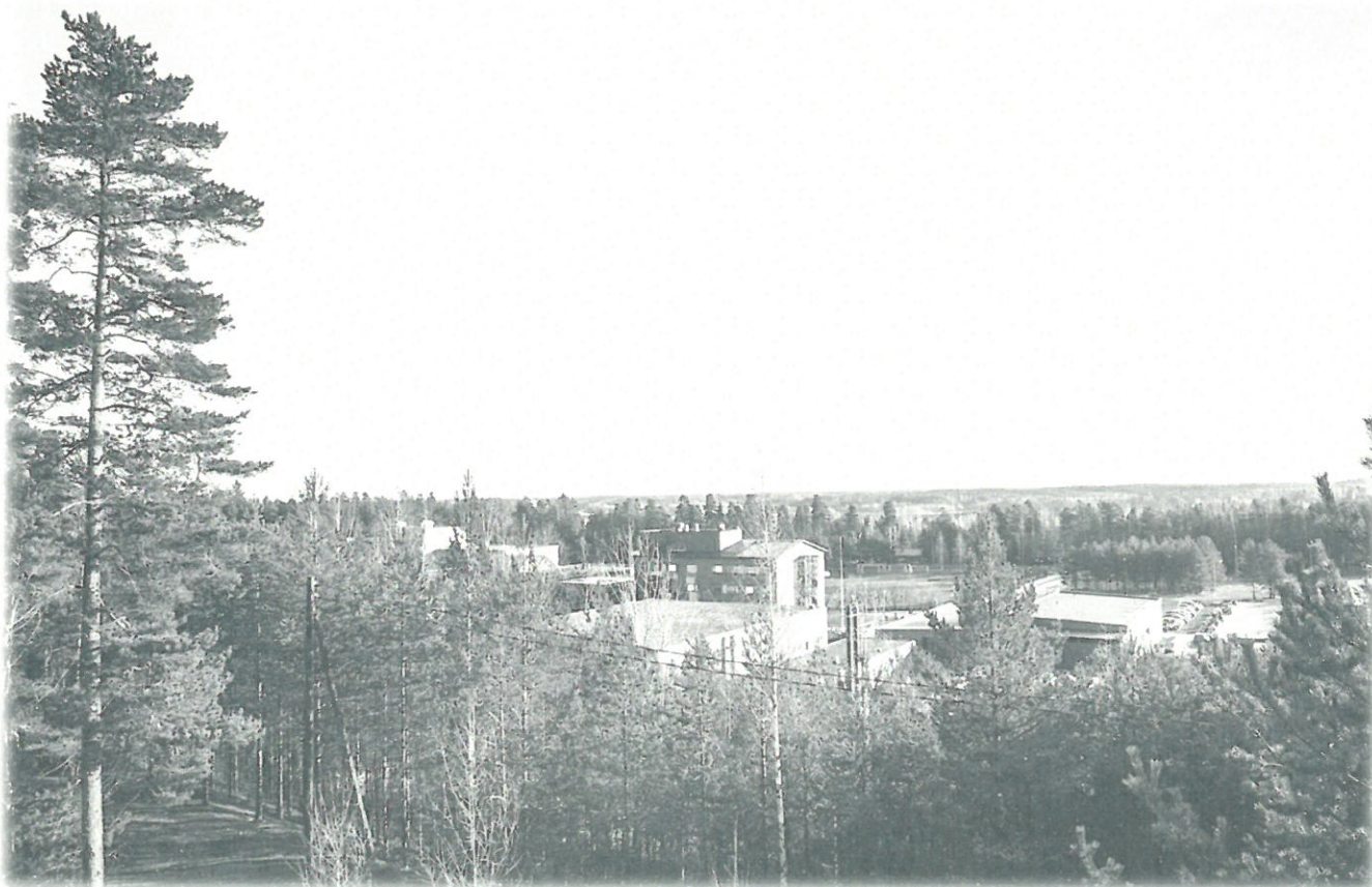
Kuva 6. Maisemakuva ylävesisäiliön katolta kohden uimahallia ja koulukeskusta
