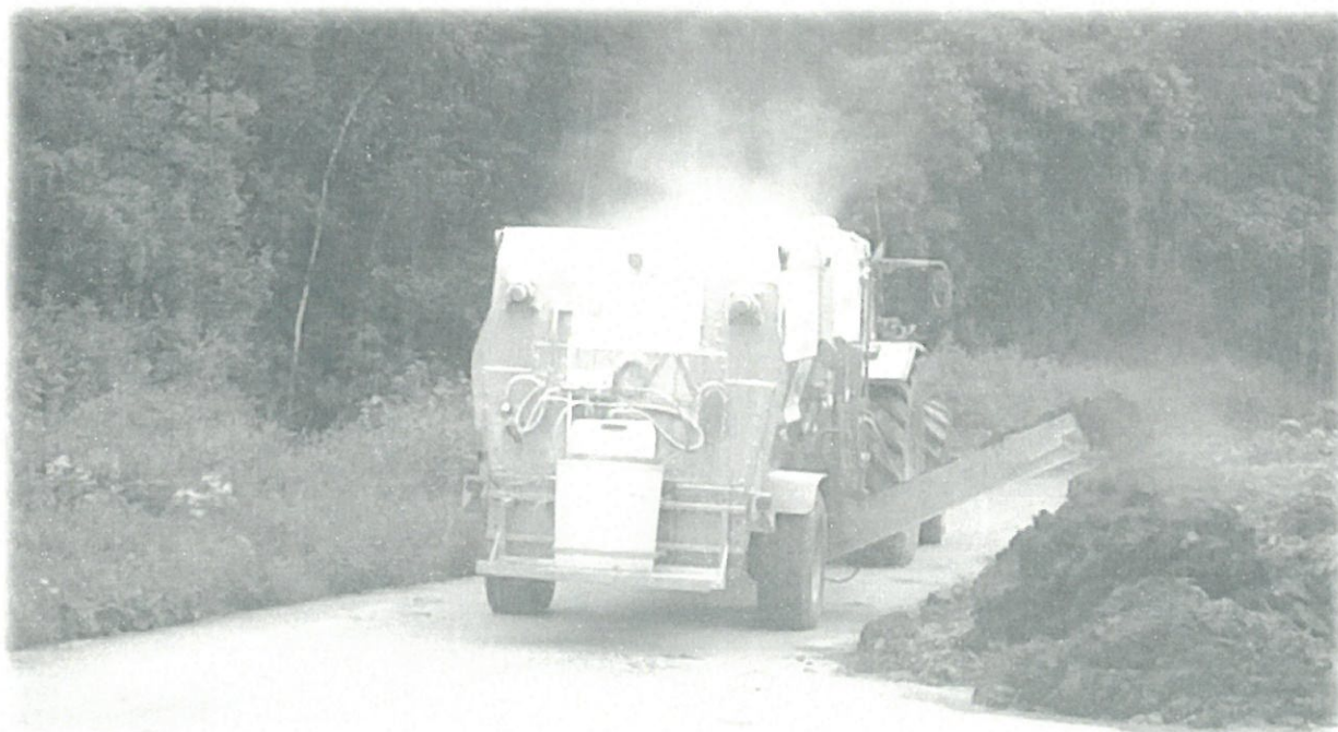
Kuva 9. Käsiteltyä jätevesilietettä puretaan varastoauimoihin Nummelan puhdistamokentällä
