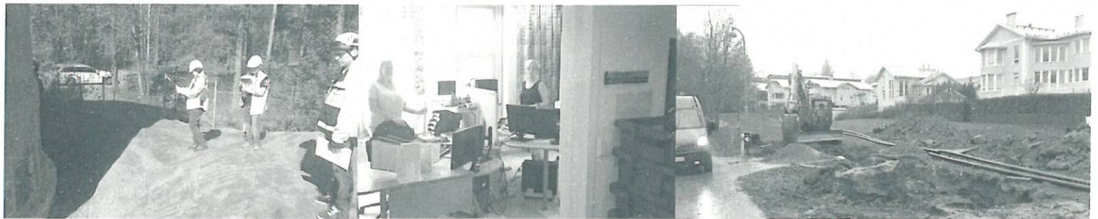
Kuva 3. Projektihenkilöitä ylävesisäiliön sokkeliä katsomassa, asiakaspalvelun muuttoa ja kirkonkylän vesijohtosaneeraustyömaa.
