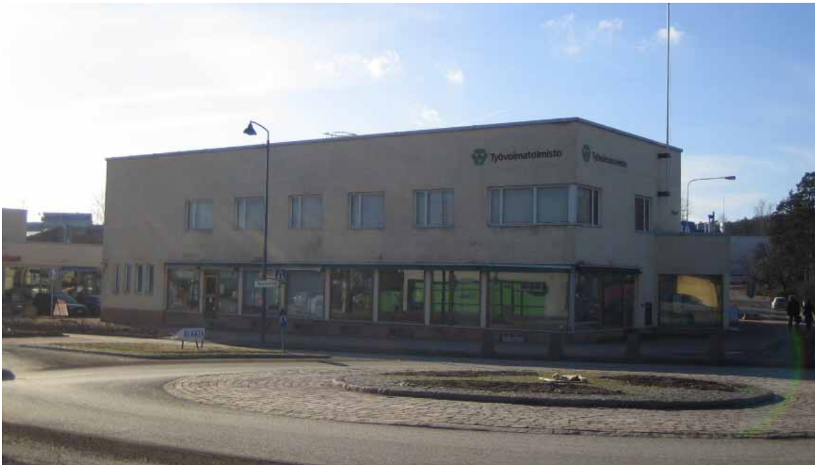
Kaavamuutosalueella oleva rakennussuojelulla suojeltu Osuusliike Auran entinen liikerakennus
