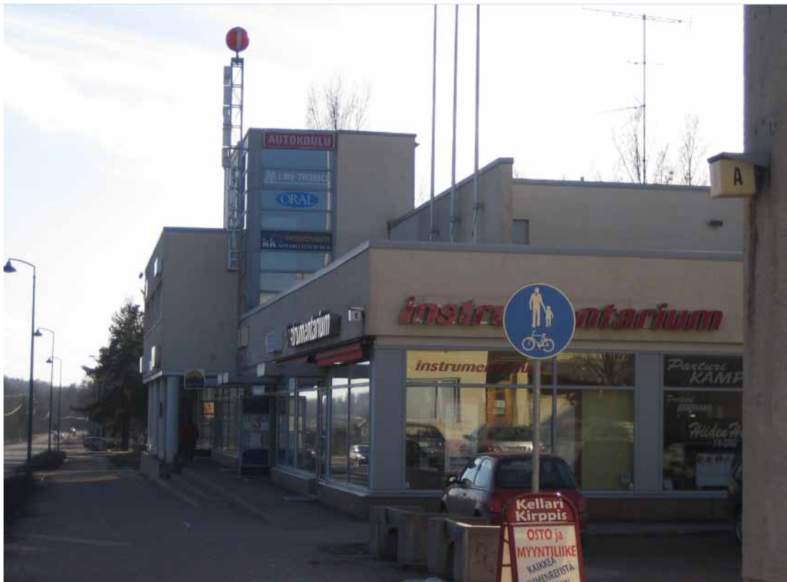
Kaavamuutosalue, Asemantien varsi, purettavaksi aiottu rakennus, jonka tilalle kaavaillaan liike- ja asuinkerrostaloa
