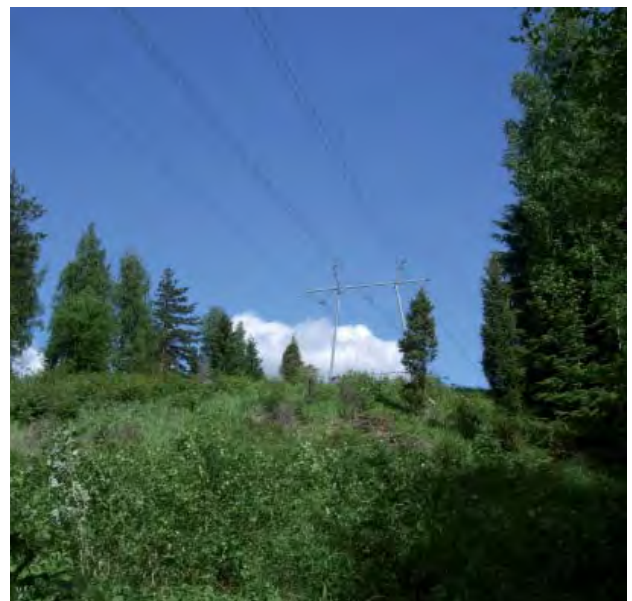
Helminharjun kaava-alueen laidalla kulkee 110 kV:n voimalinja
